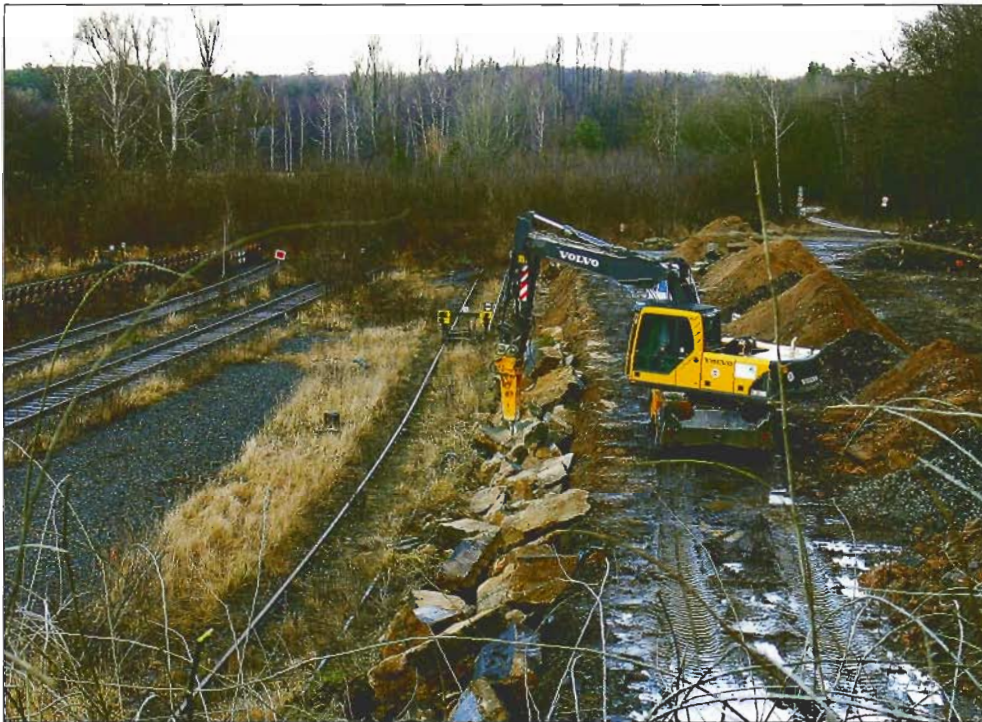
Abb. 13: Bauarbeiten zur Sanierung (Foto: www.bahnbilder.net) (im Hintergrund rechts Waldstraße zur direkten Holzanlieferung)
