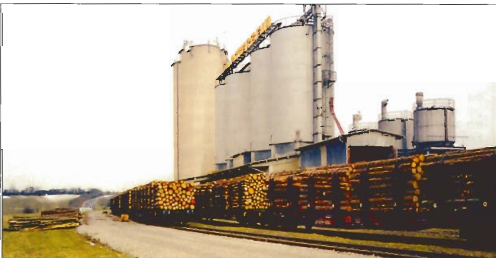
Abb. 5: Für Holztransporte befestigter Gleisanschluss
