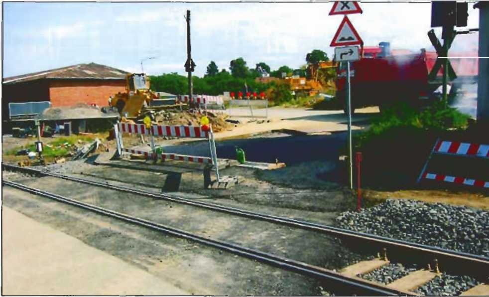
Abb. 3: Sanierung eines Bahnübergangs der Strecke Lollar–Mainzlar
