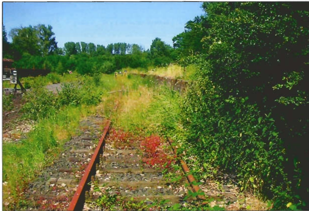
Abb. 12: Zu sanierende Verlagerampe
