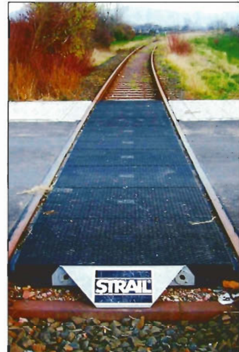
Abb. 8: Sanierter Übergang (Foto: Con Train)
