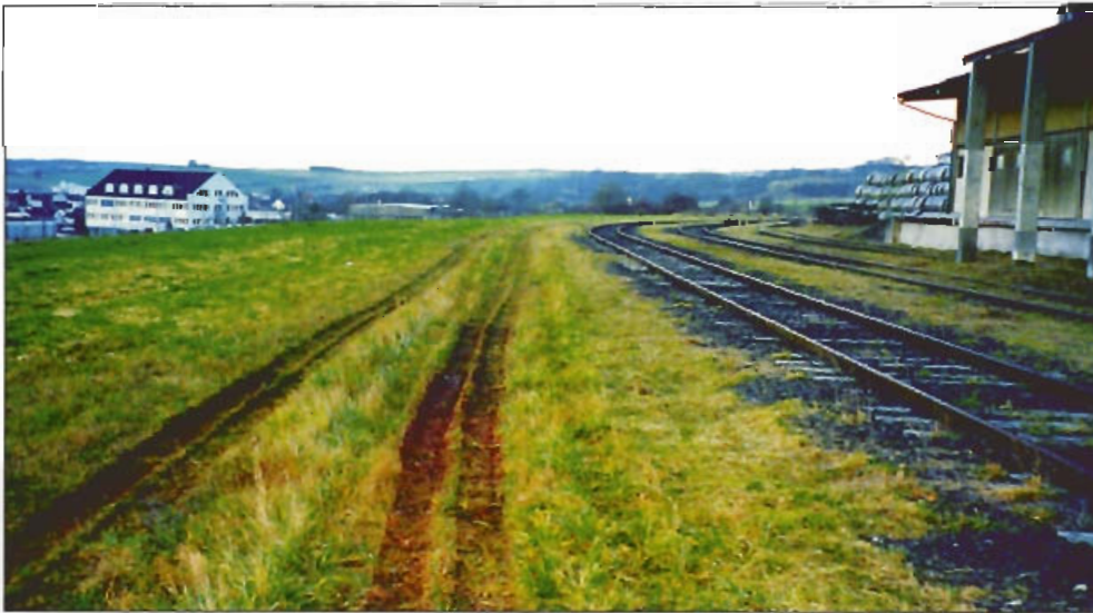
Abb. 4: Gleisanschluss in Großenlüder noch ohne Befestigung
