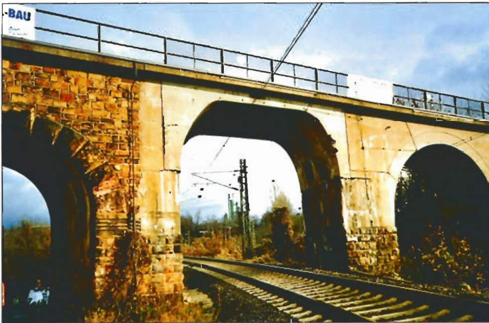
Abb. 10: Brücke über die elektrifizierte Hauptstrecke
