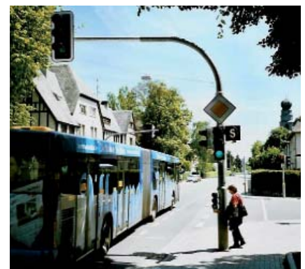
Lichtsignalanlage nach der Optimierung
