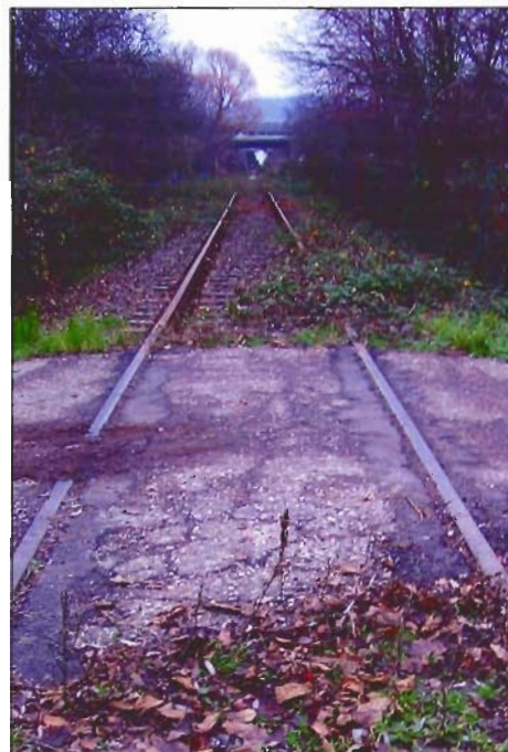
Abb. 7: Auch dieser Bahnübergang dokumentiert, wie notwendig die Sanierung war
