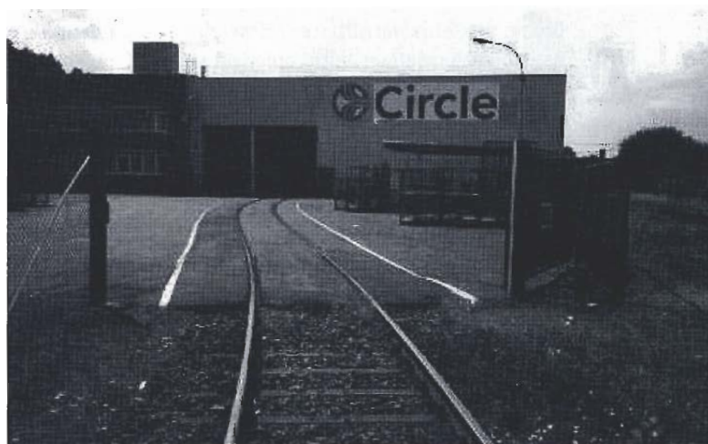
Bild 4: Gleisanschluss eines Unternehmens
