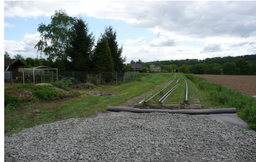
Güterstrecke zum Gleisanschluss: Landesförderung (0,48 Mio. €)
